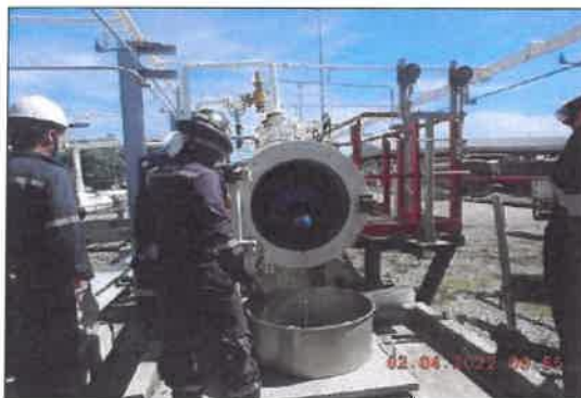
รูปที่ 2-3 การส่ง Intelligent Pig เพื่อตรวจสอบท่อส่งน้ำมัน
