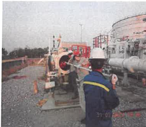
รูปที่ 2-2 การทำความสะอาดท่อส่งน้ำมันด้วย Cleaning Pig
