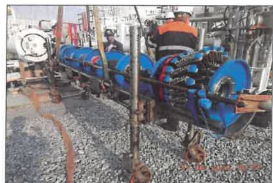
รูปที่ 2-3 การส่ง Intelligent Pig เพื่อตรวจสอบท่อส่งน้ำมัน
